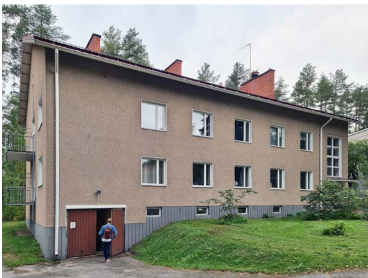
Kuva: 98. Betonisokkeli laskee asuntolan eteläpuolelta maaston mukaisesti alemmas. Talon eteläpäädyssä sijaitsee myös autotalli, jossa säilytetään tällä hetkellä pihan huoltokalustoa, kuten ruohonleikkureita.
