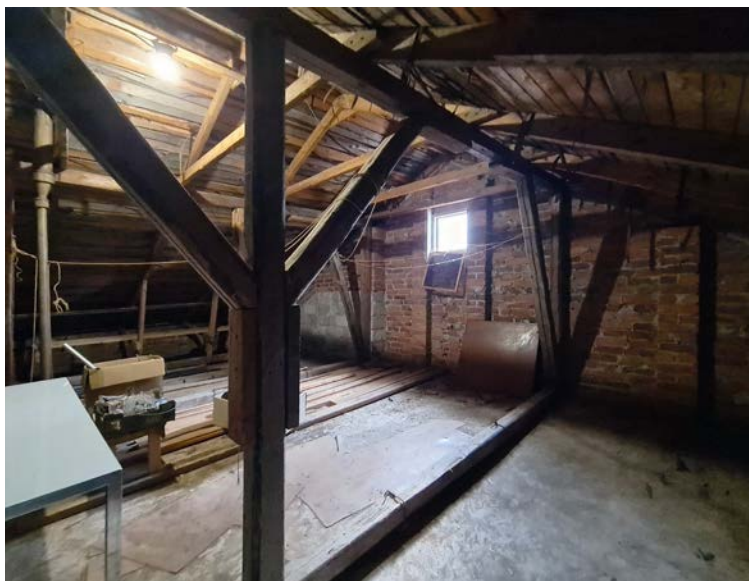
Kuva: 160. Opettaja-asuntolan ullakko ja ullakon päätyikkuna.
