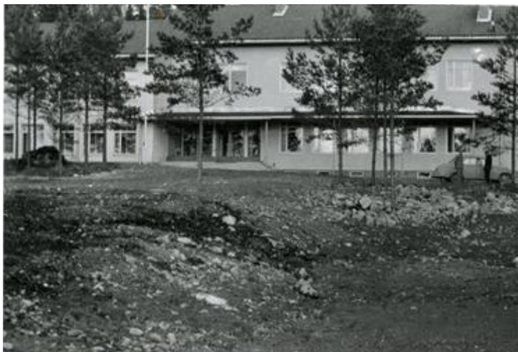
Kuva 31: Kuvassa oppilaitoksen pihan tasoitustöitä, kuva vuodelta 1955.
