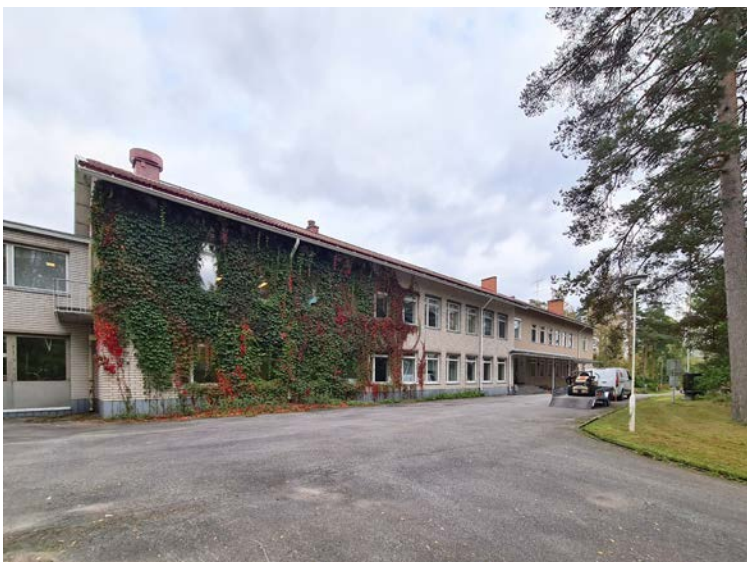
Kuva: 88. Oppilaitoksen kahitilijulkisivuisessa laajennusosassa kasvava villiviiniköynnös on vallannut suuren osan julkisivusta rakennuksen lounaispuolella.
